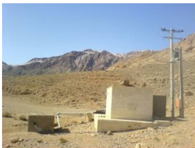
تصویر شماره (۳۴): چاه آب آشامیدنی روستاهای طاق، بق، حسین آباد، جزن و حاجی آباد در
